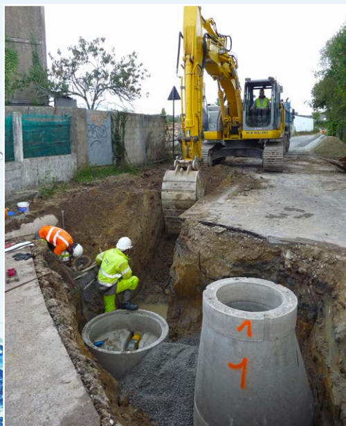
Travaux d'assainissement rue de la Mare.
