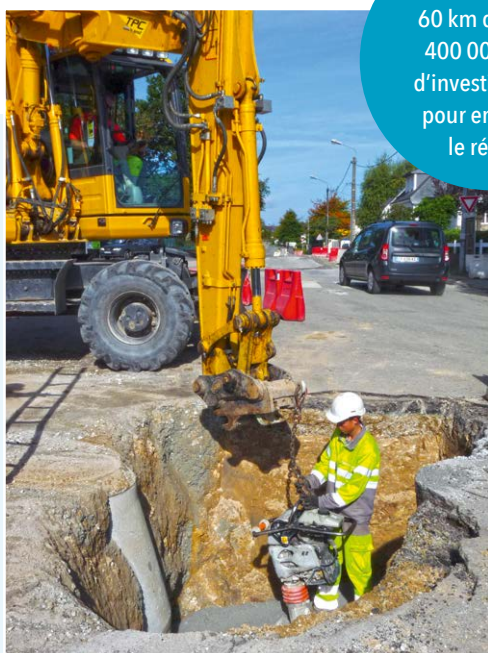
Travaux d'assainissement rue de Limur.
