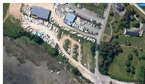
Disposition actuelle des abords de la cale de Barrarac'h
