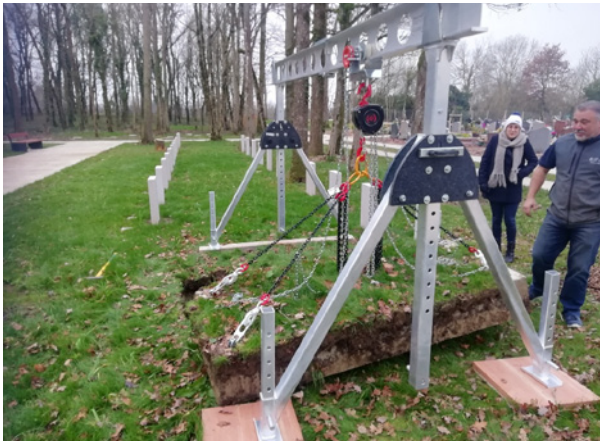
Ouverture de caveau engazonné avec chèvre et palan - Aiffres (79)
