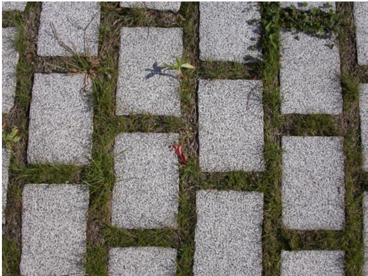
Pavage à joints engazonnés
