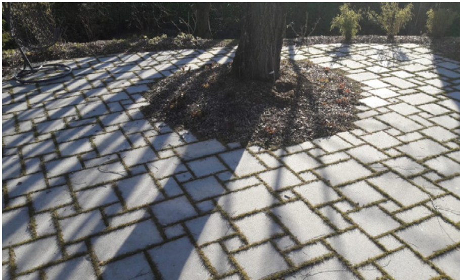
Bosquet cinéraire (pavés granit à joints engazonnés)
