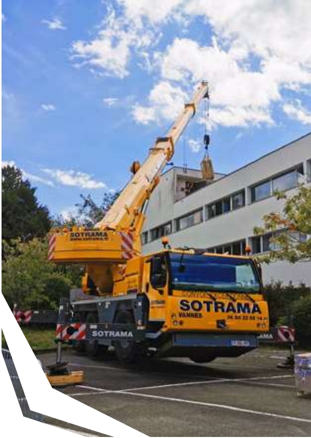
Remplacement de la chaudière de l'Hôtel de ville en septembre 2023.
