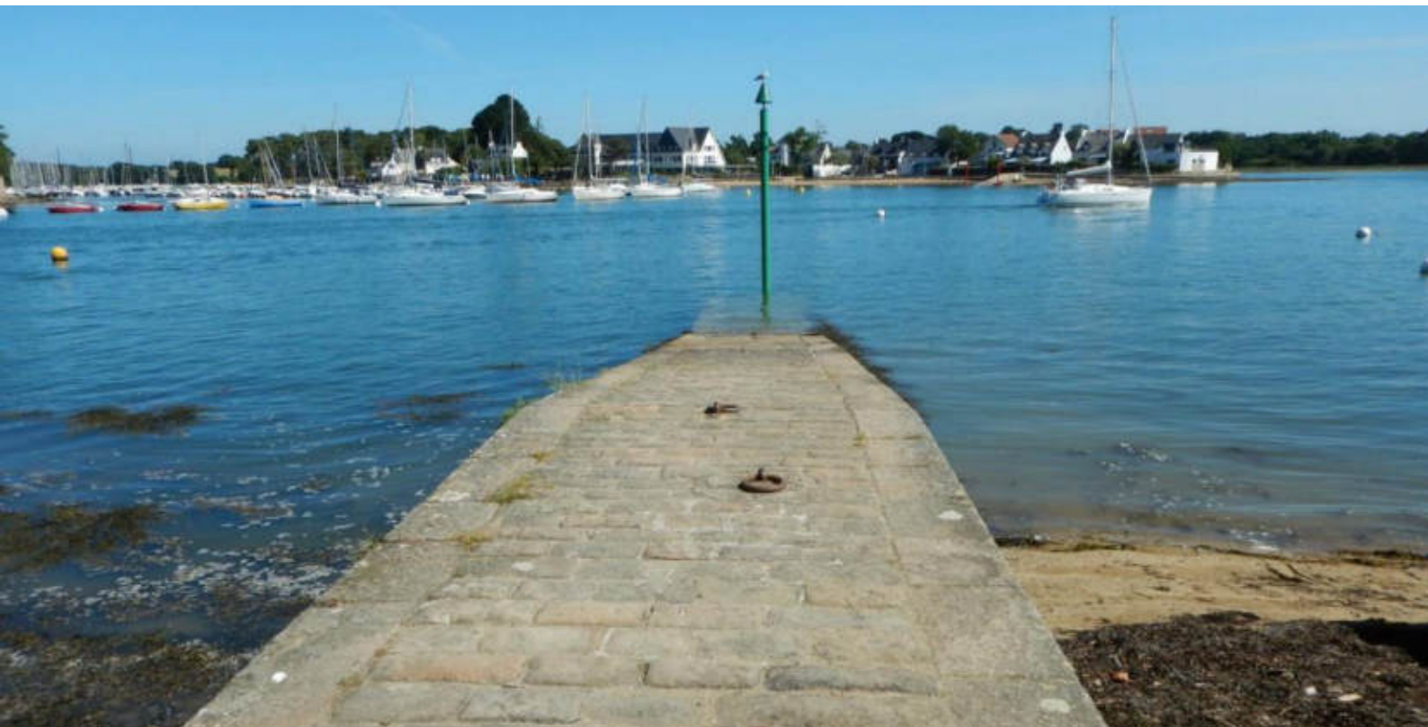
Cale de la pointe de Barrarach vue vers Conleau (Vannes)
