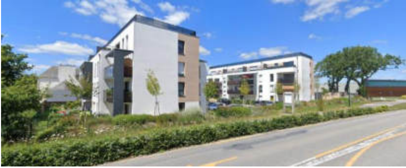
1 / Opération logements collectifs en limite Nord rue Cousteau
