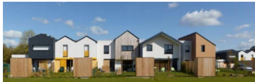
Opération groupée « Vert Buisson » à Bruz (35)
