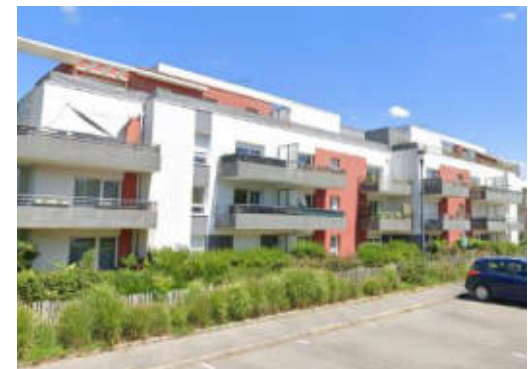
4 / Vue sur les logts collectifs rue Alexandra David Neel, à l'Est du site
