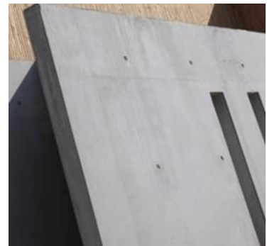
Béton banché brut
